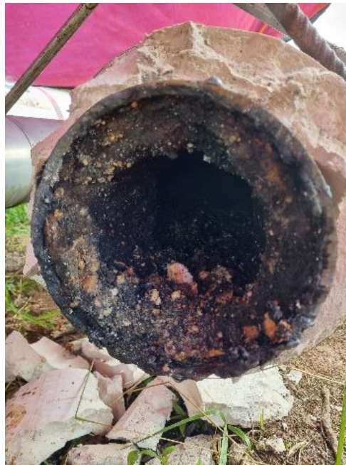
Gambar 2. Silica Scale Pada Pipa
